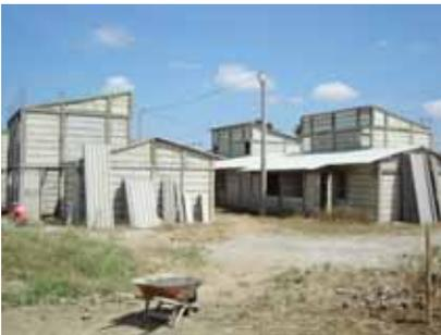
Fotografía 7. Panorámica de instalación de prefabricados confeccionados con eco-cemento, proveniente del reciclaje de cenizas volantes de hornos industriales. Palmira, Valle del Cauca.
