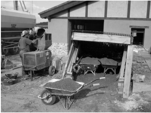
Figura 1. Vista del proceso de preparación de la tierra: Criba y pulverizadora
